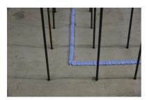
Es muss sichergestellt sein, dass sich die Raupe der **MasterMastic PU Quellpaste** innerhalb der Bewehrung befindet und eine Betondeckung von 8 cm eingehalten wird.
