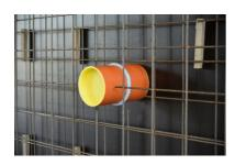
Der Einbau der vorgefertigten Durchführung erfolgt nach dem kompletten Durchhärten der **MasterMastic PU Quellpaste**.
